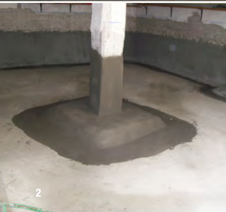
FIG. 1 Applicazione BZ 6 RS su parete verticale e pavimentazione esistente
