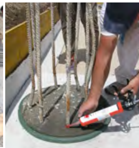
Impermeabilizzazione palo di fondazione
