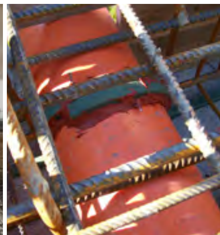
Impermeabilizzazione corpo passante con EXPANSO e AK 25
