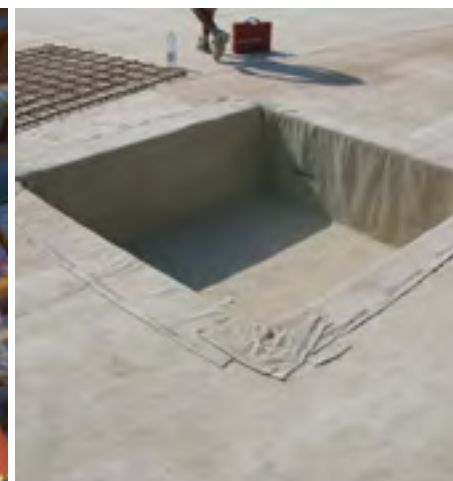
Impermeabilizzazione fossa ascensore
