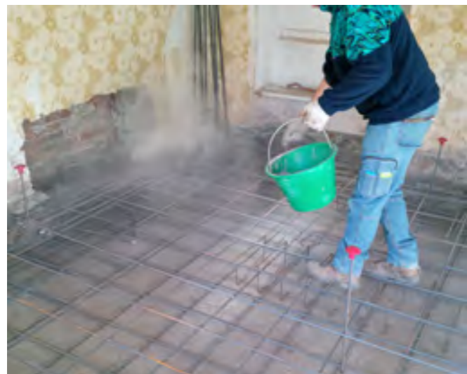
MASSETTO DI FONDAZIONE DURANTE LO SPOLVERO
