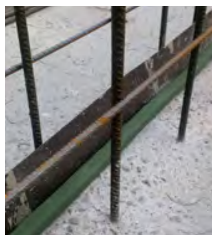
AK 25 giunto bentonitico LS 130 SG
