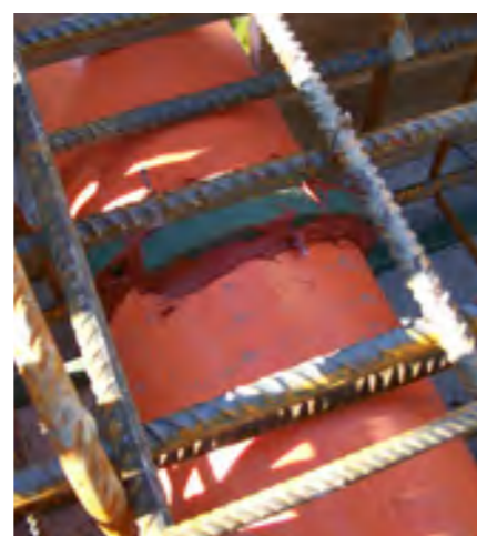
AK 25 giunto bentonitico EXPANSO sigillante idroespansivo
