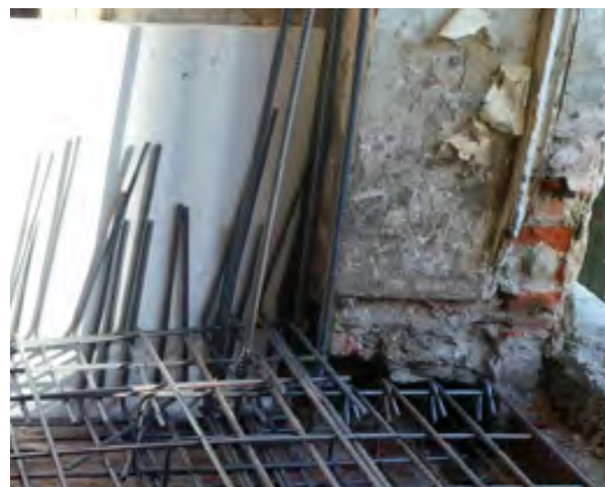
MASSETTO DI FONDAZIONE DURANTE LO SPOLVERO
