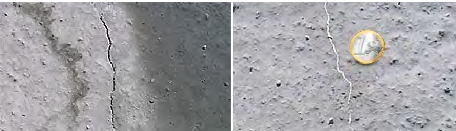
Sigilla impermeabilizzando fessurazioni fino a 0,4 mm di spessore
