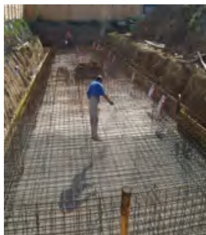
Impermeabilizzazione sotto platea
