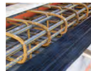
Giunti in PVC per riprese strutturali PVC CB PVC CBE
