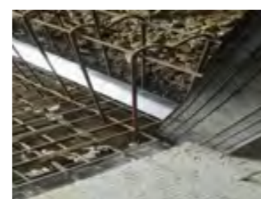
Giunti in PVC per riprese di getto PVC SB
