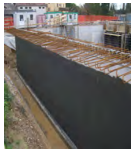
Impermeabilizzazione pareti verticali
