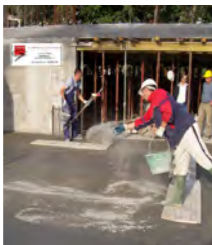
Impermeabilizzazione sopra platea
