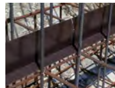
Giunto in acciaio LS 130 SG
