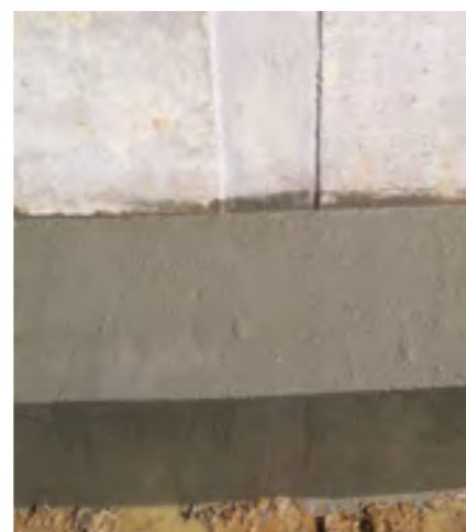
Impermeabilizzazione zoccolo di fondazione
